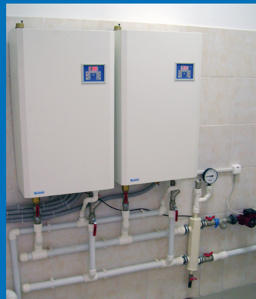
Соединение от 2-х до 32-х электрокотлов THERM в каскаде !!!
